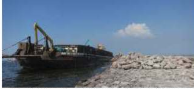
Gambar 3 Pekerjaan Unloading Batu dari Tongkang
