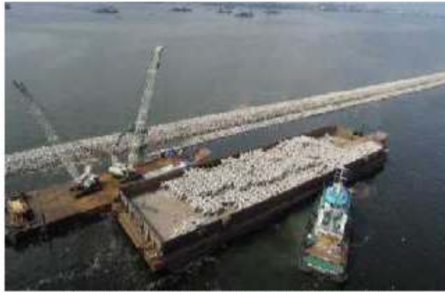
Gambar 4 Pekerjaan Instalasi A-Jack
