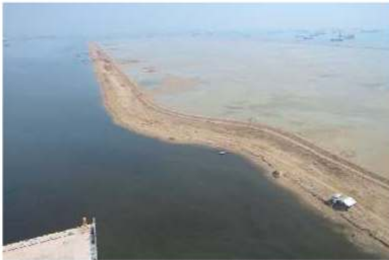
Gambar 15 Progress Pekerjaan Reklamasi (25 Juni 2016)
