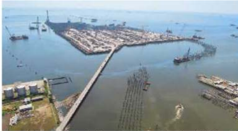
Gambar 12 Progress Pekerjaan Container Terminal I (3 Juni 2015)
