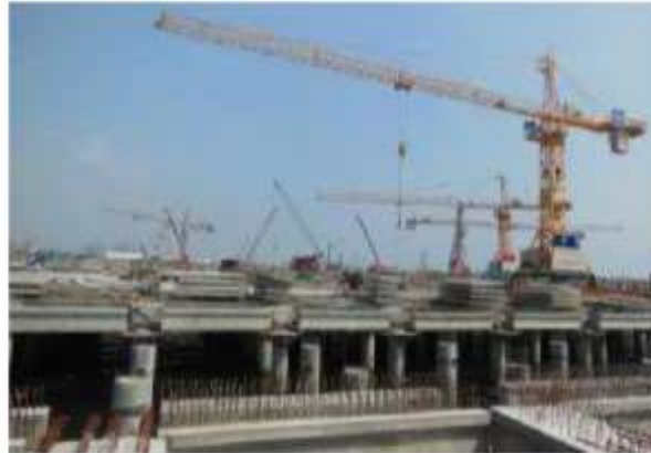
Gambar 2 Instalasi Beton Pracetak dengan Tower Crane
