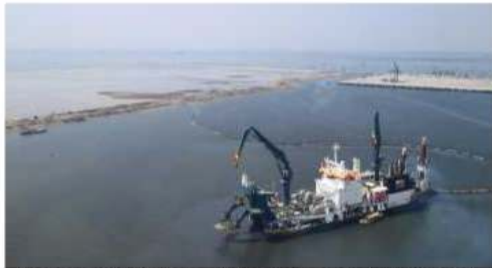
Gambar 10 Pekerjaan Pengerukan dan Reklamasi
