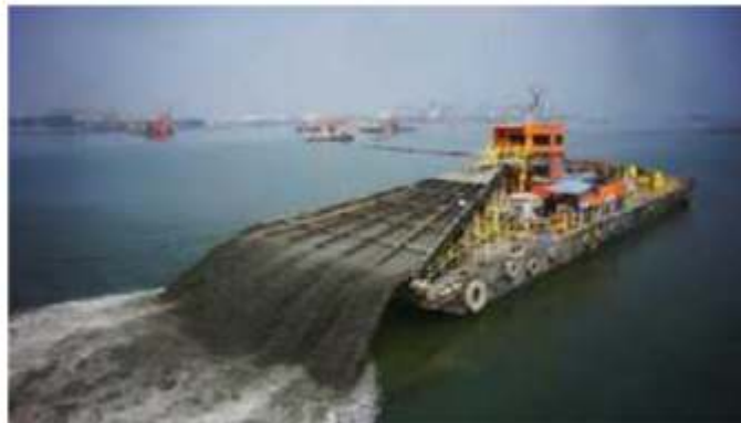
Gambar 6 Spray Pontoon untuk pekerjaan Sand Bund
