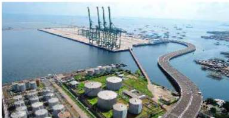
Gambar 13 Progress Pekerjaan Container Terminal I (25 Juni 2016)
