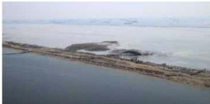
Gambar 11 Pekerjaan Pengerukan dan Reklamasi
