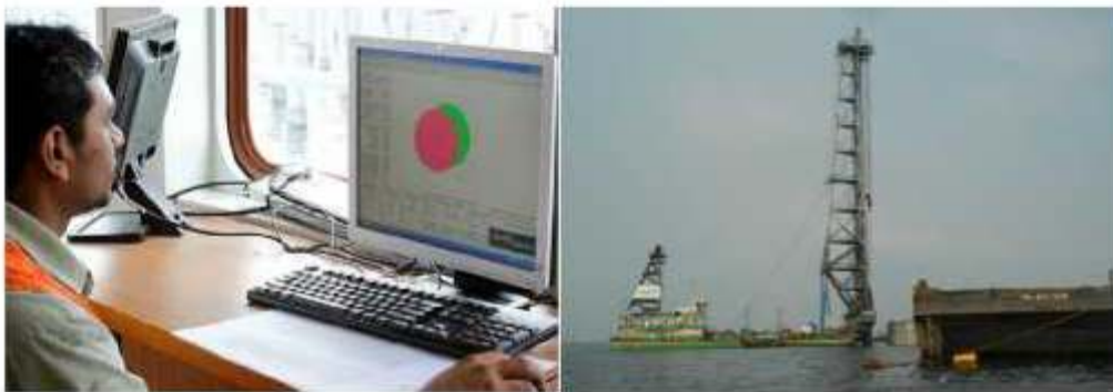
Gambar 7 Pemancangan dengan GPS
