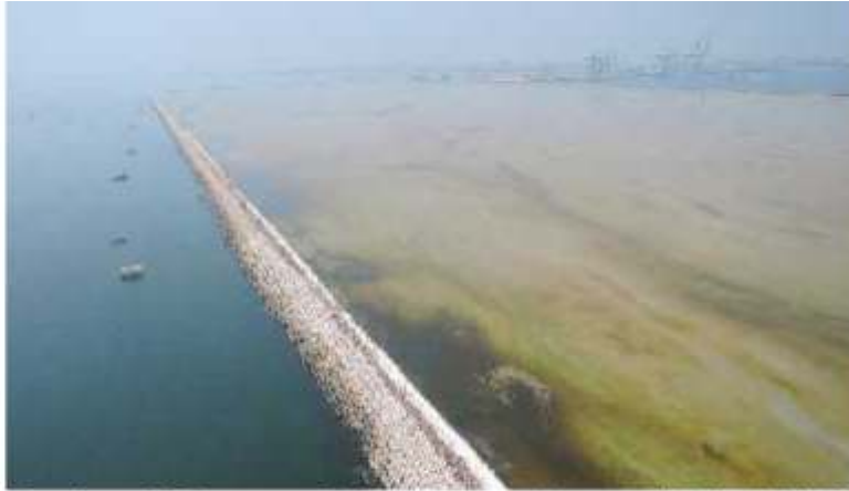
Gambar 14 Progress Pekerjaan Breakwater (25 Juni 2016)
